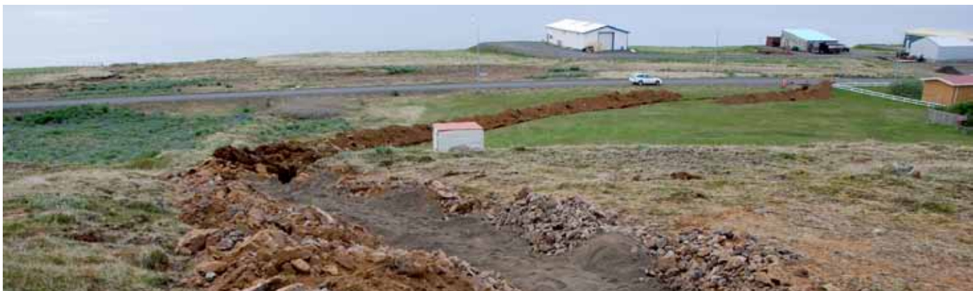
Mynd 44 Framkvæmdir á lögnum á Bakkafirði
